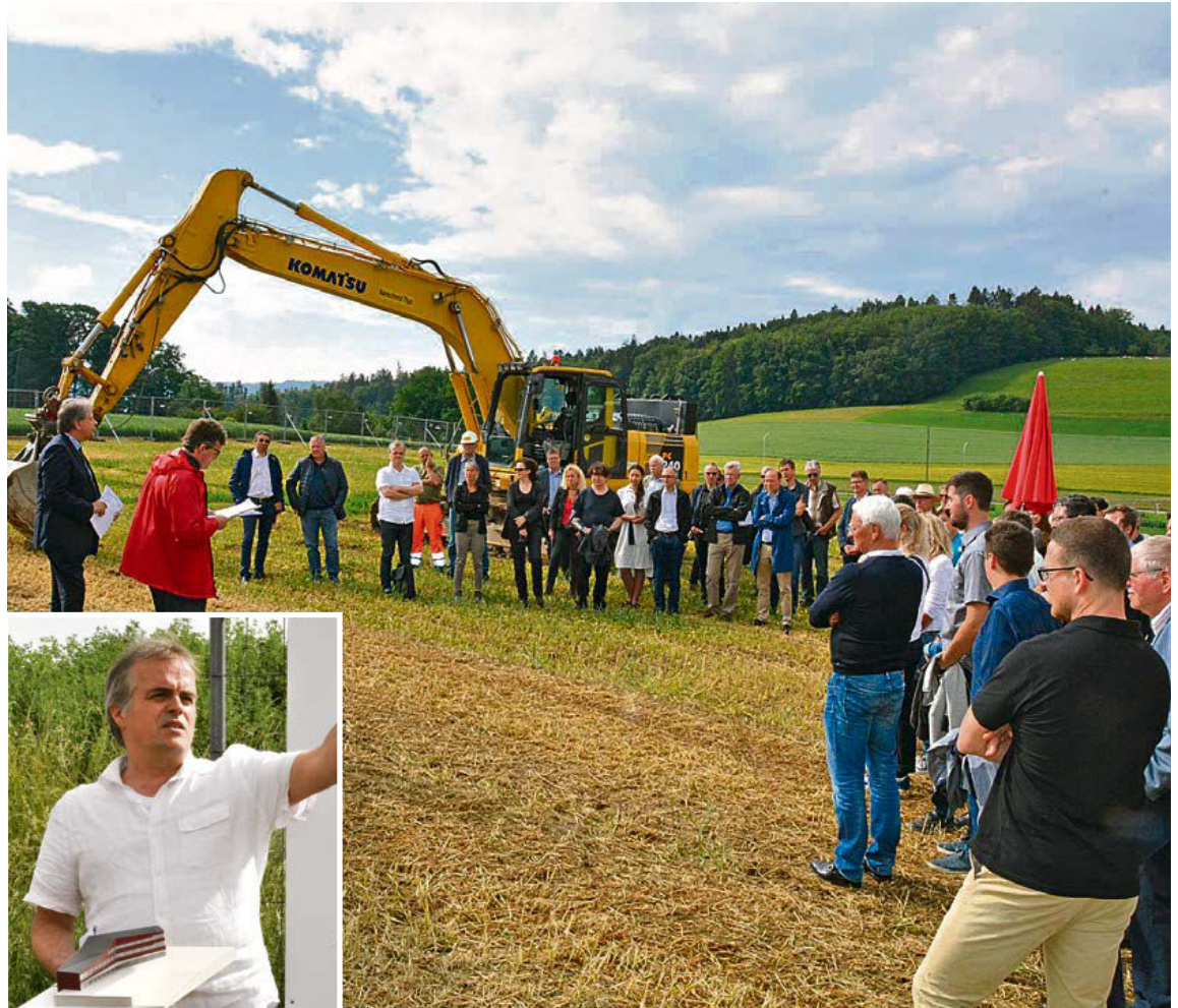
Grosser Andrang beim Spatenstich. Architekt Kord Büning-Pfaue (kl. Foto) stellte das Projekt vor. | Fotos: DB / KB
