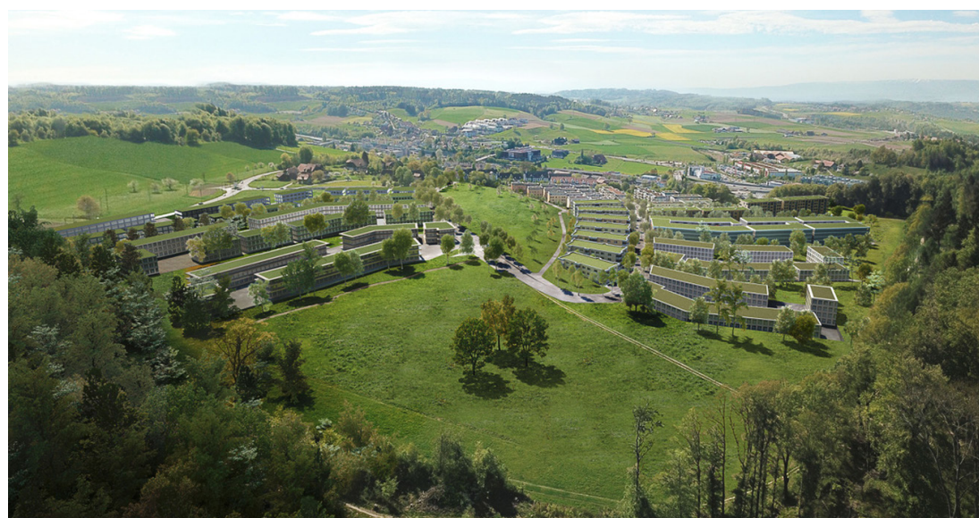
Ein grosses Baufeld im entstehenden Quartier Papillon erfüllt bereits die Eckpunkte eines Plusenergie-Quartiers. ©Papillon
